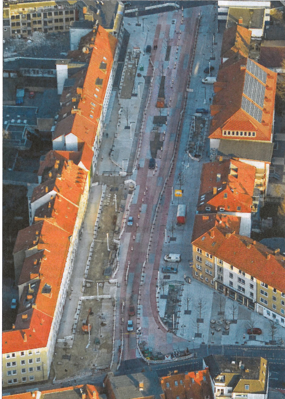
Der grau-rote Straßenasphalt ist auf dem Luftbild gut zu erkennen. Im Juni sollen die Arbeiten abgeschlossen sein und der Rosenplatz in neuem Glanz erstrahlen.
