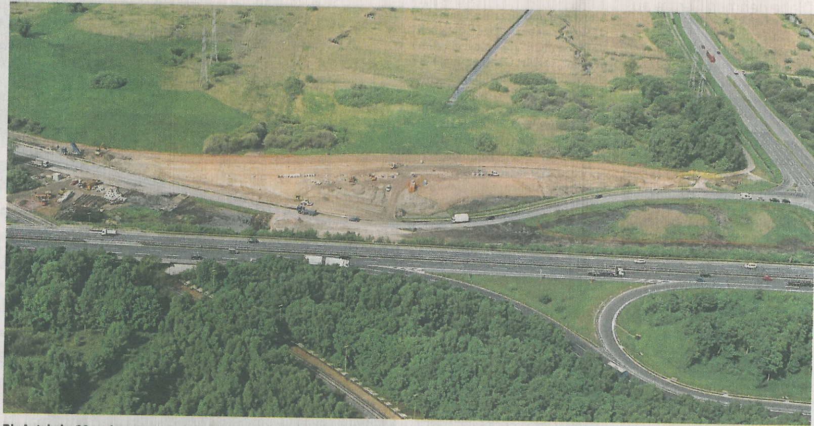
Die Autobahn 39 an der Anschlussstelle Sandkamp in Blickrichtung Westen mit der Tangente (hinten rechts) und der Großbaustelle an der Kreisstraße 115 (Mitte), die für das künftige vierte Ohr nach Westen in Richtung Naturschutzgebiet verlegt wird.
